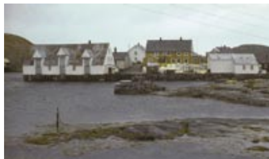
Fiskemottaket, væreierboligen og trandamperiet høsten 1977. Da var de fleste av væreierens bygninger malt hvite.
