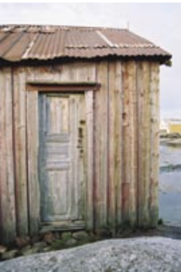
Tømmermannskledningen på Skogmobua er av seintvokst, margskåret granvirke. Foto: Pia Gravbrøt
