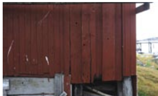
2 bilder over: Gammelbua på Heimværet er en av de eldste rorbuer i fiskeværet. Tømmerkassen er oppført av gjenbruksmaterialer. Bordkledningen består både av gjenbruksmaterialer og rekved.
