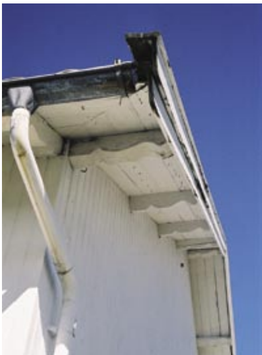
Fiskarheimen - en av få bygninger i været med store takstikk og utvendig utsmykning. Bygningen har utskjæringer på synlige takåser og høvlet og profilert kledning.
