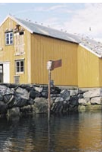
Trandamperiet med kledning av gran. Foto: Hilde A. Tokle
