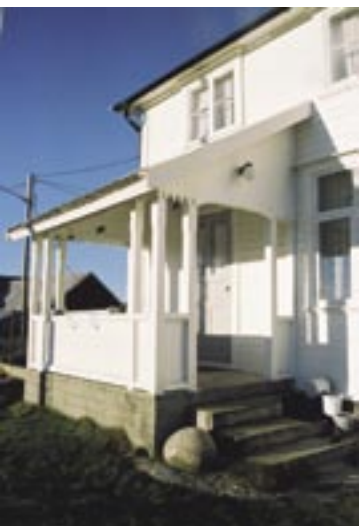
Telegrafbygningen - kledd med seintvokst, høvlet og profilert furumaterial. Foto: Pia Gravbrøt
