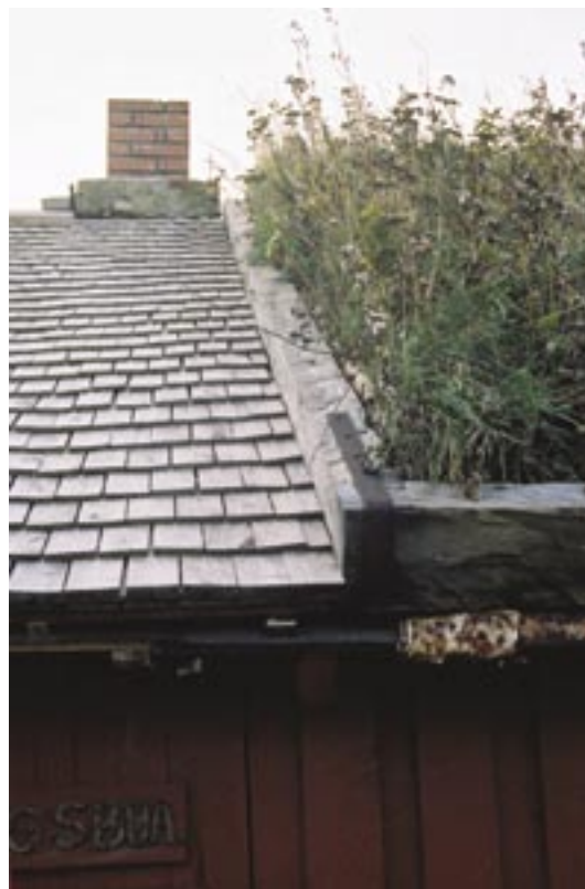
Staværingsbua - nylagt tak etter gammel tradisjon, med torv over buromsdelen og spon over skjådelen.
