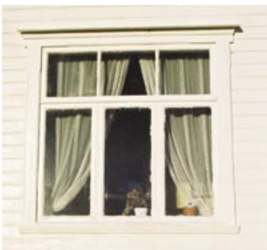
Telegrafbygningen har høvlede og profilerte vindusomramninger og kledning.
