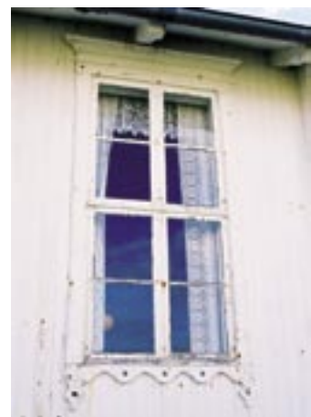
Bilder ovenfra: Enkelt vindu uten spesiell utsmykning gjenbrukt i stor-naustet på Heimværet. Nyrestaurert vindu i trandamperiet. Vindu med høvlet og profilert omramming i Fiskarheimen.
