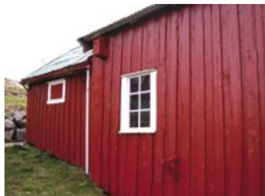
2 bilder over: Naust tilhørende et av de to tidligere leilendingsanleggene på Heimværet. Bordkledningen består både av gjenbruksmaterialer og rekved. Foto: Pia M. Gravbrøt
