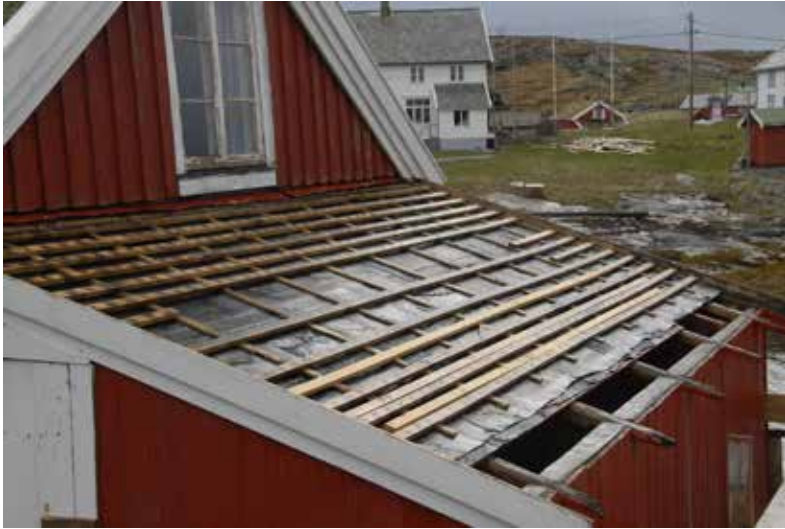
Utskifting og istandsetting av tak. Foto: Pia Maria Gravbrøt
