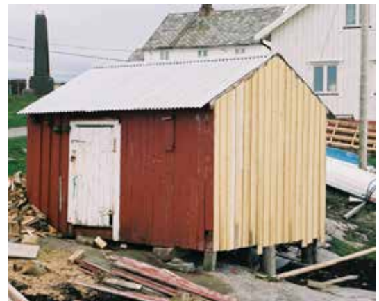
Mist mulig av det originale materialet skal skiftes ut, men av og til må en hel vegg få nye kledning på grunn av råteskader. Foto: Hilde Arna Tokle Yri
